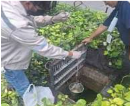
บ่อพักน้ำสุดท้ายก่อนระบายออกสู่ท่อระบายน้ำสาธารณะ
